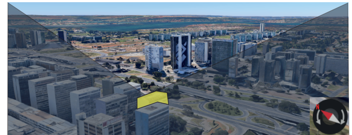
Edifício maristela - Visão do setor norte.
